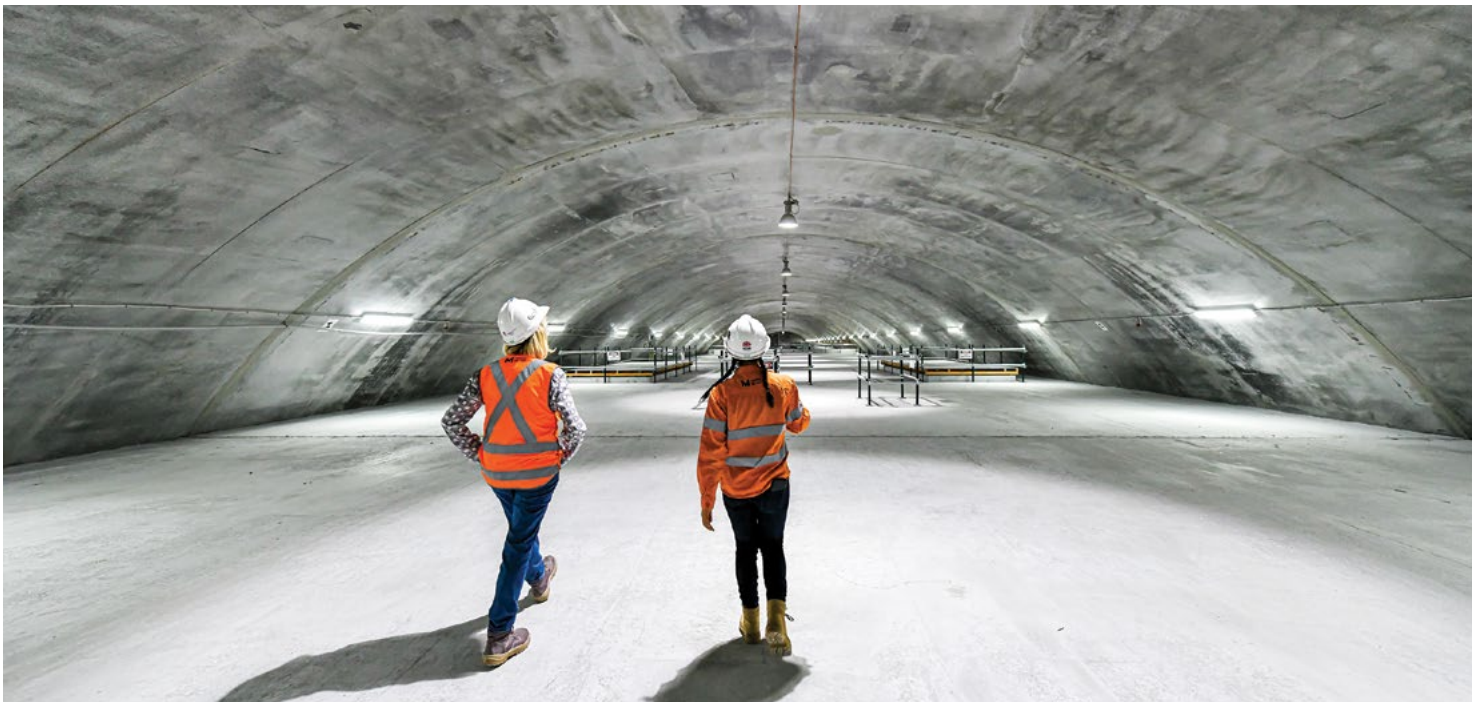
Sydney Metro City & Southwest プロジェクトの地下空洞
