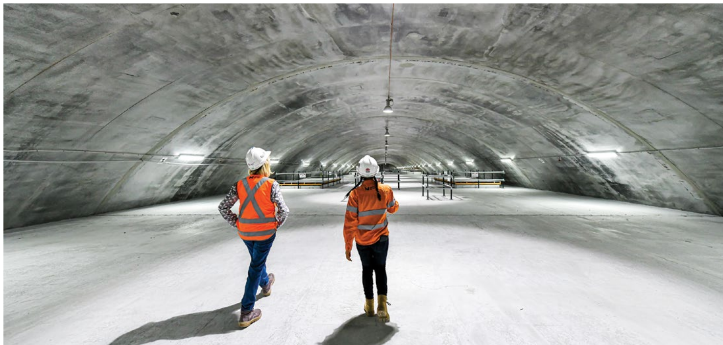
โพรงอุโมงค์ในโครงการ Sydney Metro City & Southwest
